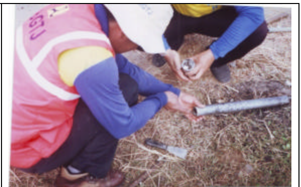
Pengambilan sample untuk uji kadar air lapangan di Km 154+130
